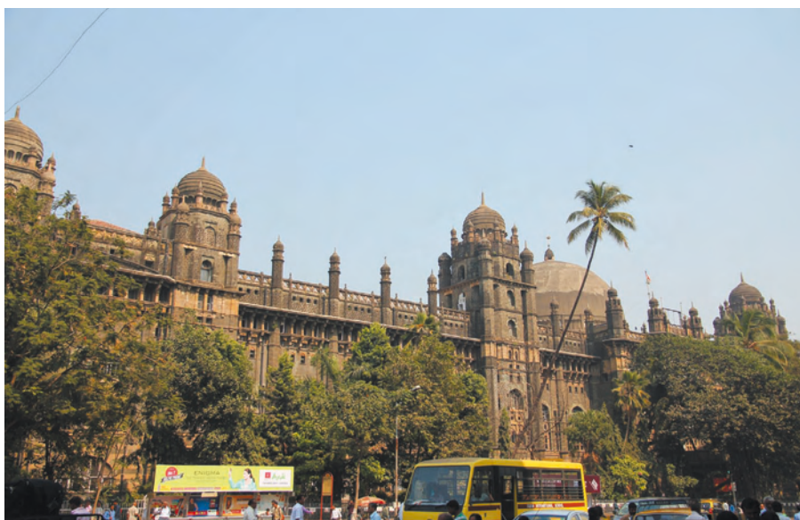
Budynek Poczty Głównej. Mumbai, fot. Anna Lewicka
