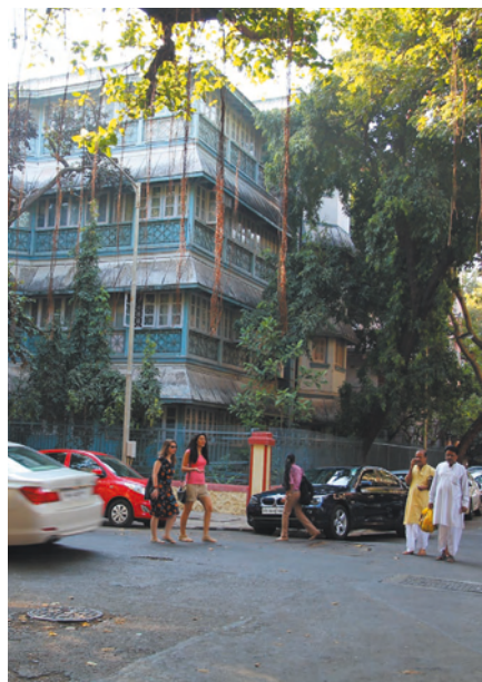
Budynki w dzielnicy Colaba, Mumbai, fot. Anna Lewicka
