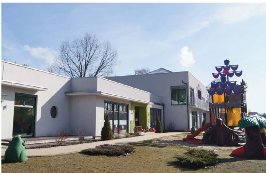
Niedługo szkoła przeniesie się do nowej siedziby w Żyrardowie.
